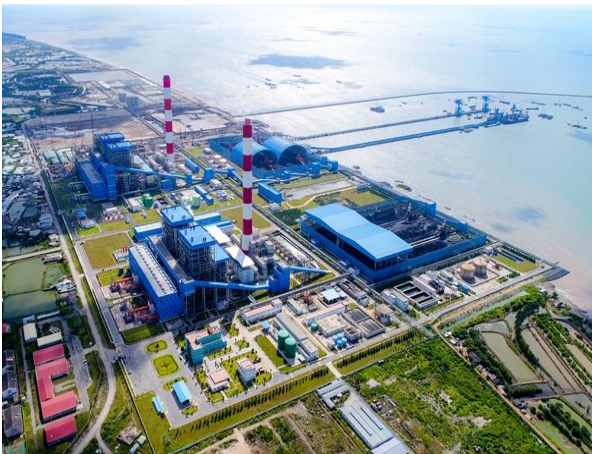
Hình 8.1: Toàn cảnh Trung tâm điện lực Duyên Hải
